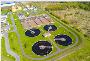
Agua y aguas residuales
